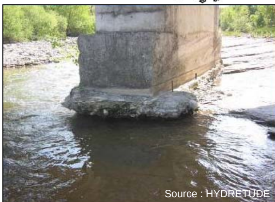
Photo 2 : L'Ouvèze à Rompon (Ardèche) : pont déchaussé par blocage du transport sédimentaire.
